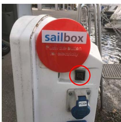
Si le voyant lumineux indiquant que le courant passe dans le bateau au niveau du câble ne sonne pas, il se peut que le fusible ait sauté. Sur la borne électrique à terre, il y a un bouton que tu peux alors actionner.
